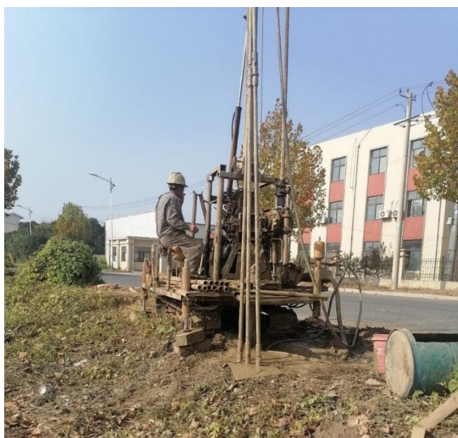
照片 1-1 工程地质钻探施工（ZT1）
