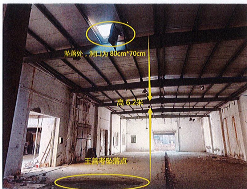
图 2 事故现场照片
