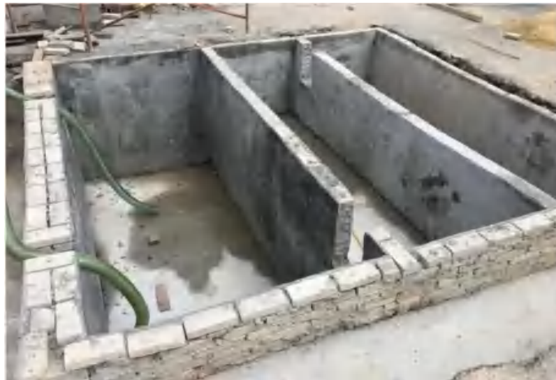
图 4-2 车辆冲洗、车间冲洗沉淀池模型
