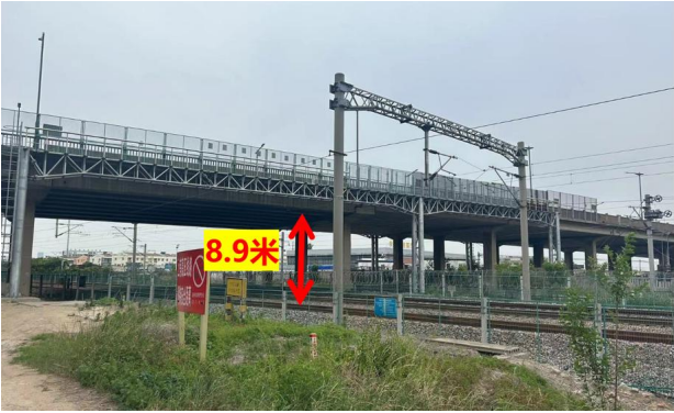
图 5-5 G25 长深高速上跨陇海铁路桥下净空
