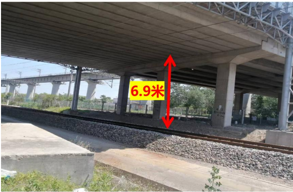
图 5-6 310 国道上跨陇海铁路桥下净空
